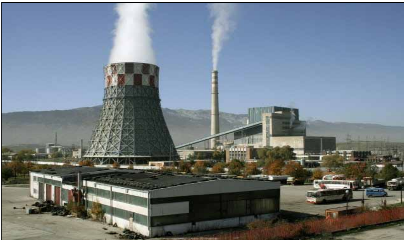
Panorama Rudnika i Termoelektrane Gacko
